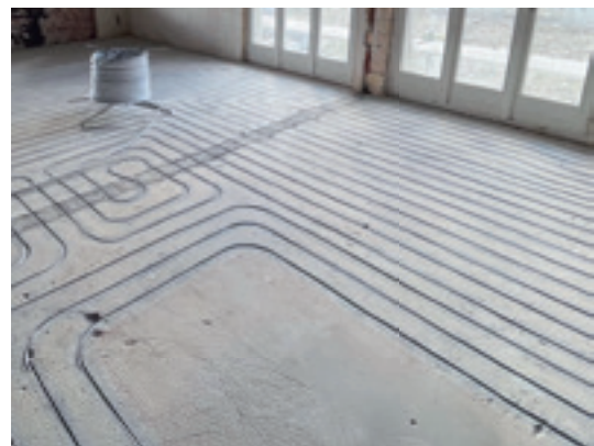
Tubes de chauffage par le sol fraisés ultérieurement dans une chape adhérente existante.
