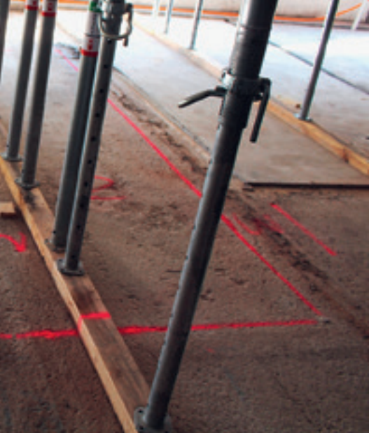
Tracé du décapage du béton avec indication de la profondeur en centimètres.
