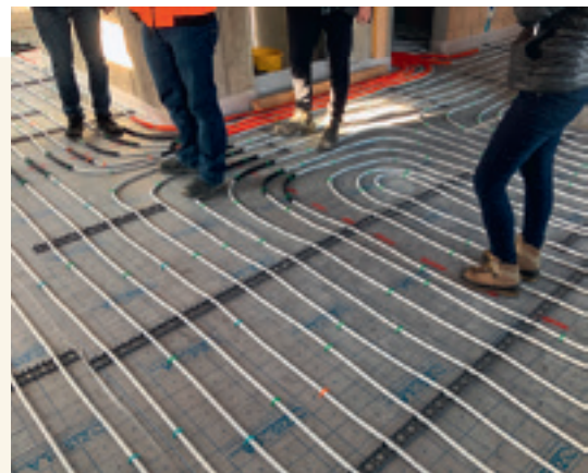
Remplacement complet de la chape, y compris le nouveau chauffage par le sol.
